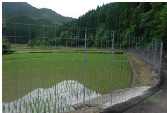
侵入防止柵の整備
