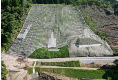
令和4年度災害関連緊急 治山事業 亀野地区(高原町)
