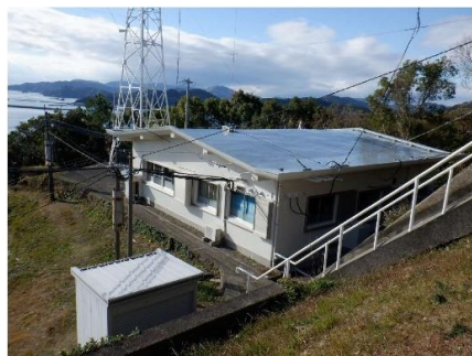
図20 無線局局舎の改修
