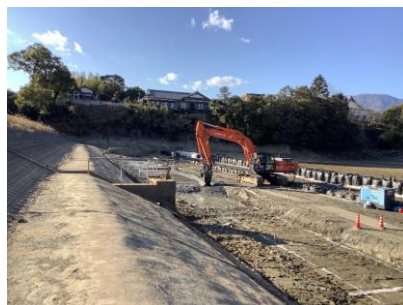
図23 ため池対策工事
