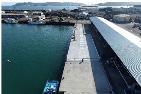
図19 岸壁の整備（門川漁港）
