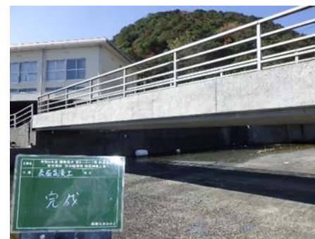
図23 橋梁の補修（南浦漁港）
