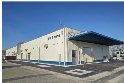
図10 HACCP対応の施設整備
