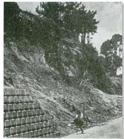
切取斜面の崩壊(1971年)
