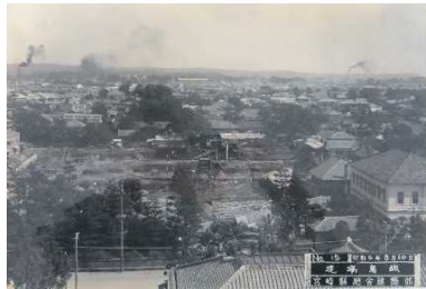
昭和6年8月の建築現場全景
