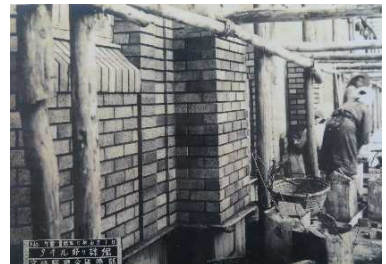
庁舎外壁のタイル貼り
