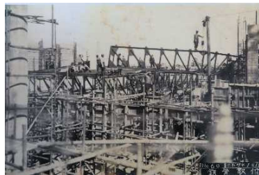
昭和7年1月鉄骨の取付
