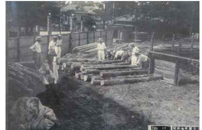
基礎となる松の杭の検査
