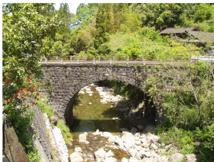
入下橋（北郷村 明治44年架設）
