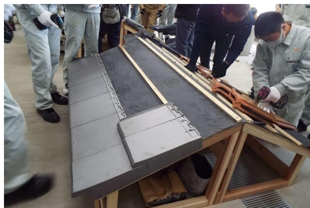
かわらぶき作業の様子
