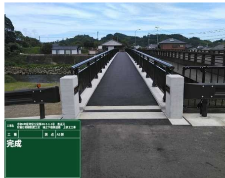
(1)② 周辺景観との調和に配慮した 道路工事 (日南市：県道元狩倉日南線 〔城之下橋側道橋〕)
