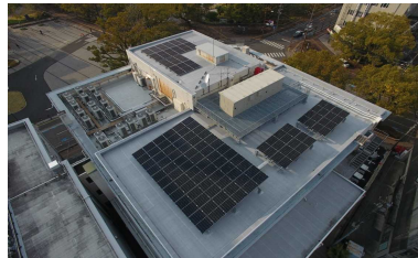
1-(2) 7号館屋上に太陽光パネル設置
