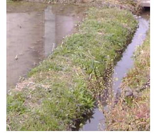
整備前の土水路
