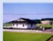
農業集落排水施設
