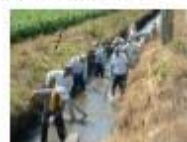
水路の泥上げ
