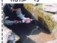
水路のひび割れ補修
