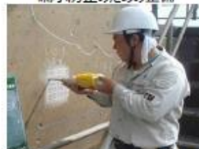
老朽化した施設の機能診断
