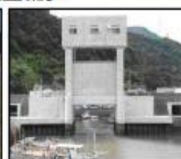
津波・高潮対策としての水門整備
