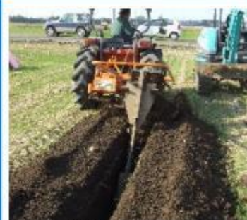
暗渠排水の整備
