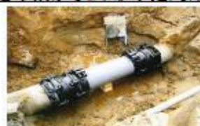
漏水防止のための整備
