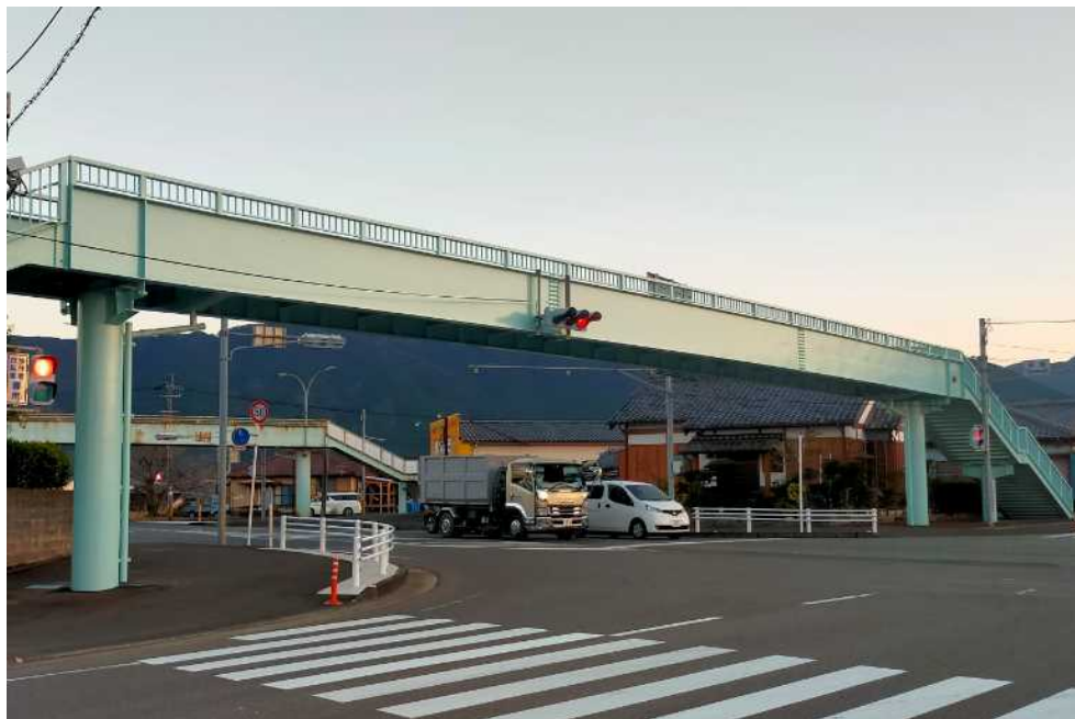
国道269号 寺町1号横断歩道橋
