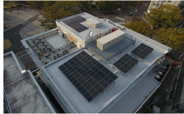
1-(2) 7号館屋上に太陽光パネル設置
