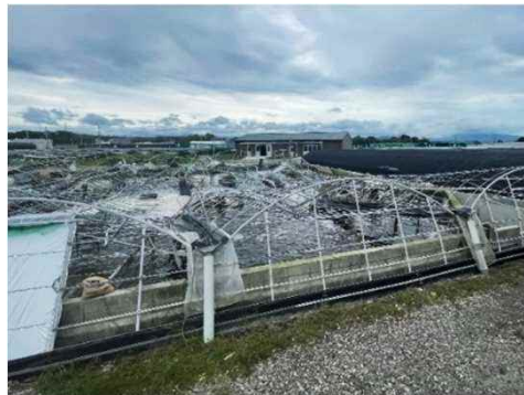
図8 突風による養殖施設の被害
