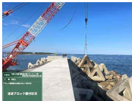
図19 防波堤の整備 (青島漁港)
