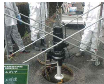
図23 集落排水施設の保全工事(富士漁港)
