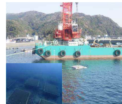
図3 藻場礁設置工事
