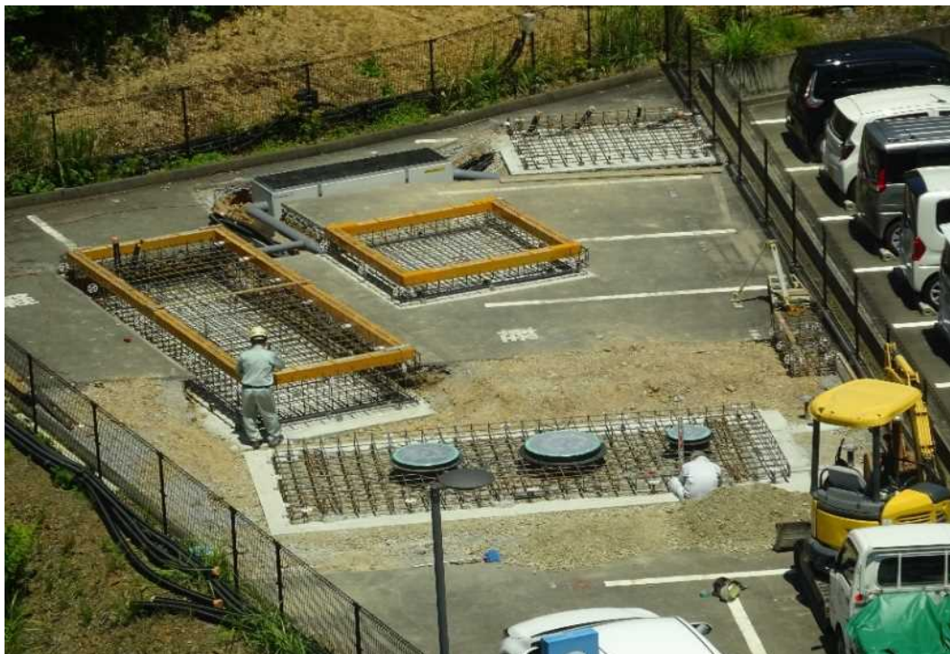
現在増設中の自家発電設備(奥)、地下燃料備蓄タンク(手前)
