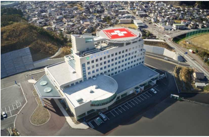
耐震構造鉄骨造 6階建て 屋上ヘリポート 高台に位置している(標高25m)
