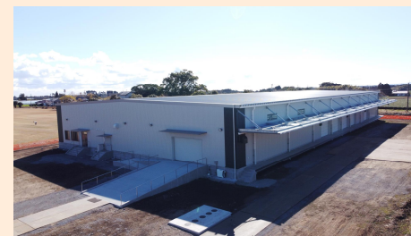
災害支援物資拠点施設
